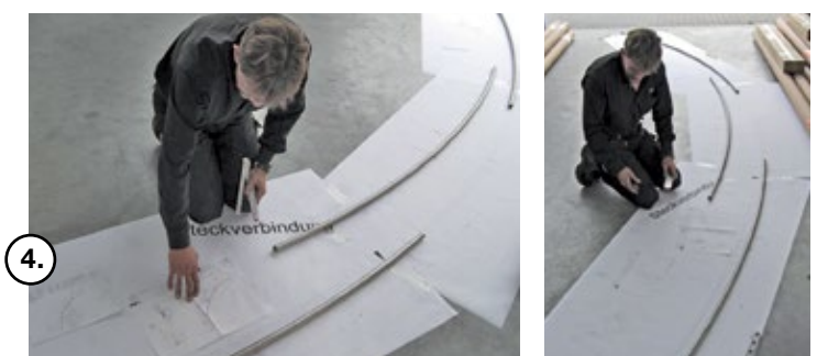
4. Die Produktionszeichnungen im Maßstab 1:1 gehören zum Lieferumfang, somit haben die Monteure vor Ort eine optimale Übersicht.
